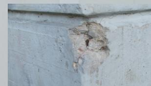
Schadensbilder Beton - Großflächige Abplatzungen infolge Bewehrungskorrosion
