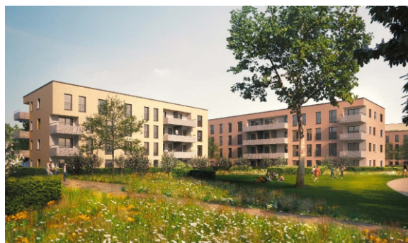
Gebäude B, Neuenburgerstraße
