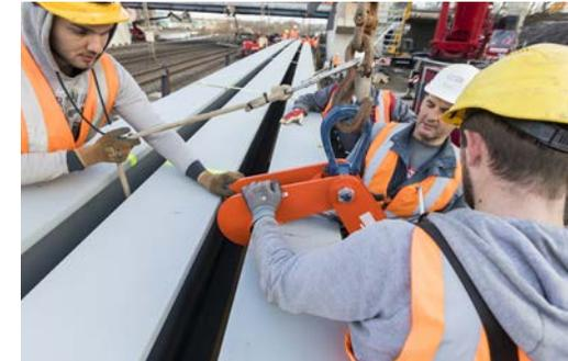
damit die Stahlkolosse millimetergenau platziert werden konnten. Wenn diese sogenannten Walzträger in Beton (WiB) montiert sind, eine Faserzementplatte und die Querbewehrung eingebaut sind, kann betoniert werden – ohne dass dafür die Bahnstrecke nochmals gesperrt werden muss!
